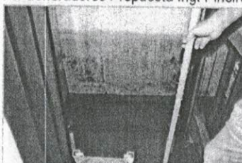
Fosa Ascensor 07 Feb.2014
